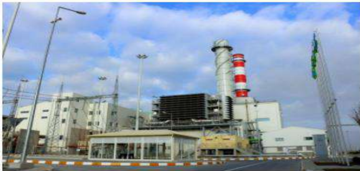
Рис.3 Вид Навоийской ТЭЦ с применением ПГУ
